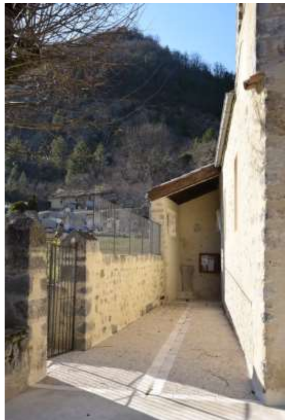
Façade de l'église son parvis et les rambardes
