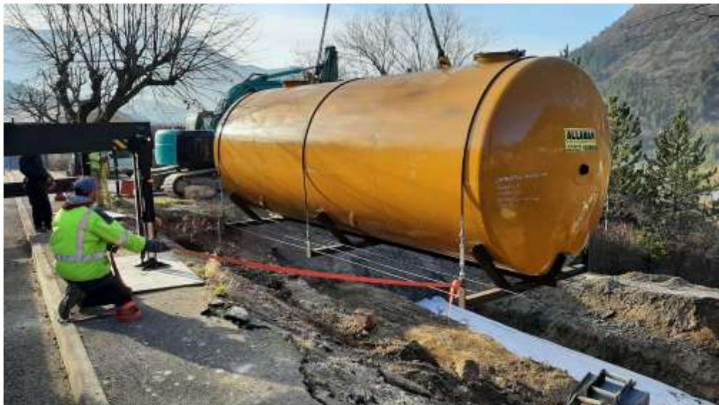
Une cuve de 60 mètres cubes est enterrée à côté du parking de l'auberge de l'Oule. Cette cuve permet de protéger la partie basse du village contre les risques d'incendie.
